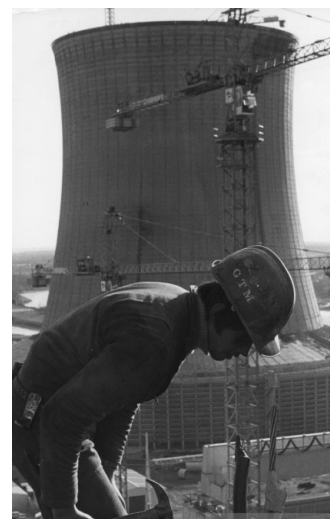
Ouvrier sur le chantier de la centrale nucléaire de Saint Laurent-des-Eaux.
